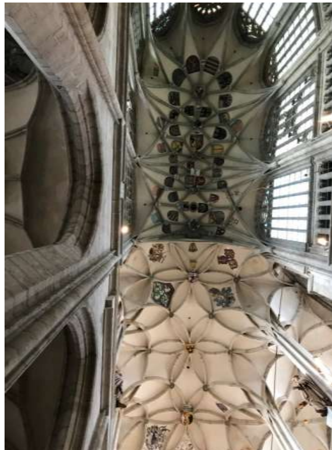
Strop chrámu Sv. Barbory
